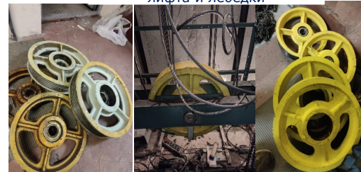
Отводные блоки кабины лифта и лебедки
