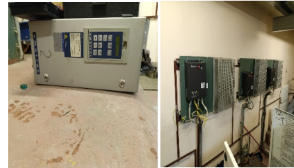
Отводные блоки кабины лифта и лебедки
