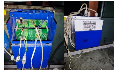
Блок управления дверями кабины
